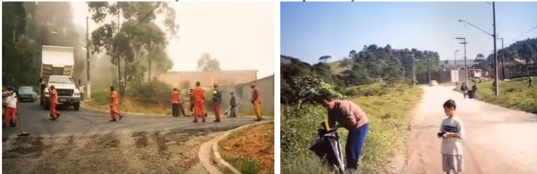
Realização do asfalto e mutirão para catação de lixo
